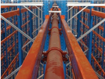
Τοποθέτηση In Rack sprinklers
