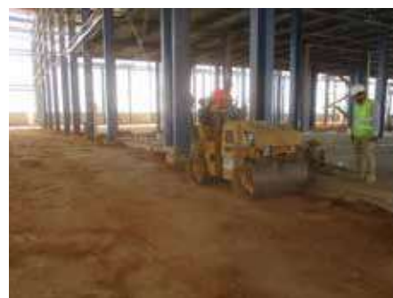
Εικ. 9A: Προετοιμασία υπόβασης
