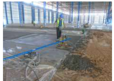
Εικ. 11B: Μηχανική λείανση
