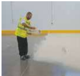
Εικ. 1 : Επισκευή υποστρώματος & απομόνωση λοιπών στοιχείων
