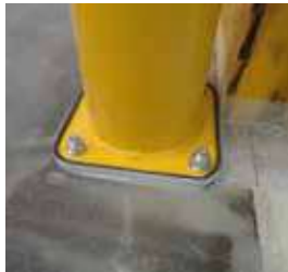
Εικ. 1 : Επισκευή υποστρώματος & απομόνωση λοιπών στοιχείων
