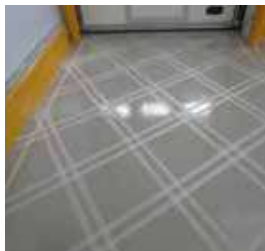
Εικ. 3 : Σφράγιση αρμών & εποξειδική διαγράμμιση
