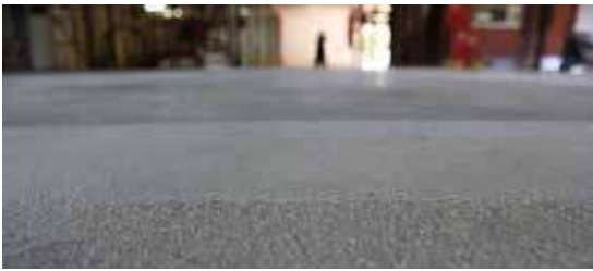
Εικ. 5 : Τελική επιφάνεια κατασκευαστικού αρμού μετά τη λείανση
