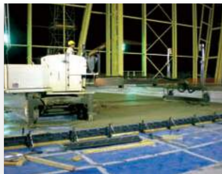
8. Διάστρωση σκυροδέματος με χρήση Laser screed και τοποθέτηση αρμοκαλύπτρων.
