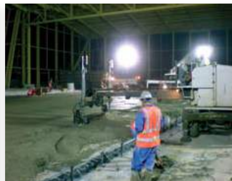
9. Διάστρωση σκυροδέματος με Laser screed.
