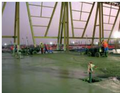
7. Κατασκευή δαπέδου (βράδυ) στο Emiri Hangar.
