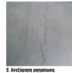
3. Ανεξάρτητη ρηγμάτωση.
