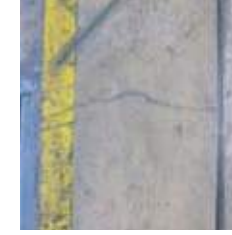
4. Ρηγμάτωση στις ράμπες.
