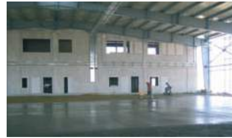
10. Φράγμα υδρατμών &amp; διάστρωση χαλαζιακής άμμου.
