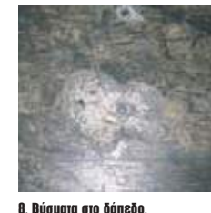
8. Βύσματα στο δάπεδο.
