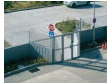
ΦΩΤ. 08. Σήμανση περιβάλλοντος χώρου.
