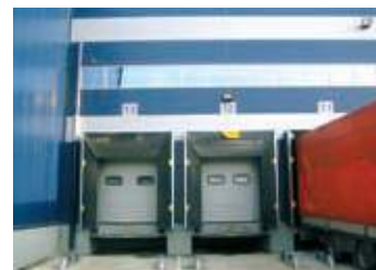
ΦΩΤ. 12. Κάμερες περιβάλλοντος χώρου.
