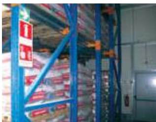
ΦΩΤ. 10. Σήμανση ενεργητικής πυροπροστασίας.
