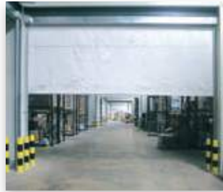
ΦΩΤ. 6. Εγκαταστάσεις παθητικής πυροπροστασίας- πυροκουρτίνες.
