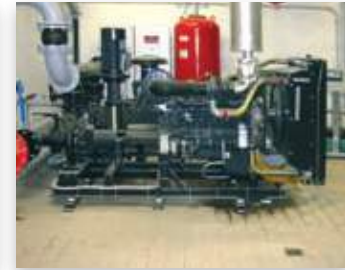
ΦΩΤ. 9. Πυροσβεστικό συγκρότημα Μ.Υ.Π.Δ.
