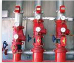
ΦΩΤ. 10. Διατάξεις δικτύου ενεργητικής πυροπροστασίας.
