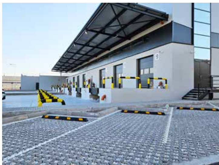
Noval Property – Δευτερεύων χώρος φορτοεκφόρτωσης ▲
