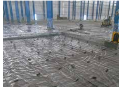
Εικ. 11A: Εγκατάσταση οπλισμού
