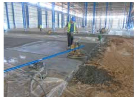
Εικ. 11B: Μηχανική λείανση
