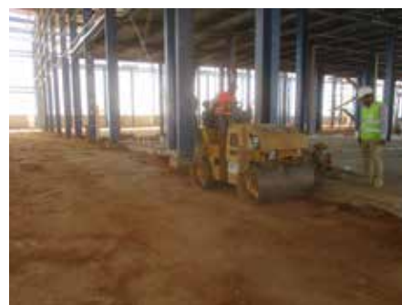
Εικ. 9Α: Προετοιμασία υπόβασης
