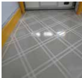
Εικ. 3 : Σφράγιση αρμών & εποξειδική διαγράμμιση
