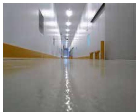
Εφαρμογή αυτοεπιπεδούμενης & τελικής εποξειδικής στρώσης
