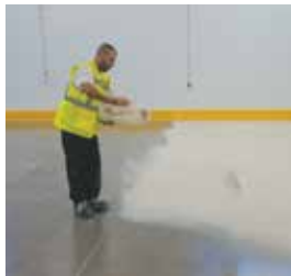
Εικ. 1 : Επισκευή υποστρώματος & απομόνωση λοιπών στοιχείων
